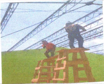
Foto1: SE OBSERVA LA SOLDADURA DE REFORZAR LA COSTANERA
