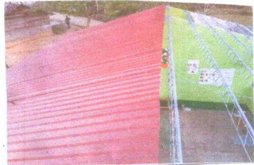
Foto 4: OBSERVACION COLOCACION DE LAS LAMINAS TITROQUELADAS
